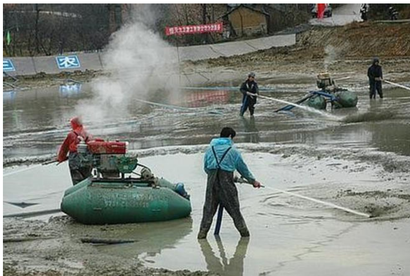
图 5.2- 2 水力冲挖清淤现场
