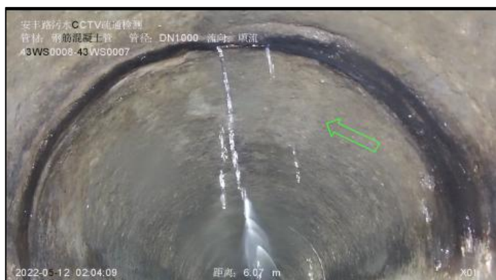
图 3.2- 3 管网渗漏示意图图
