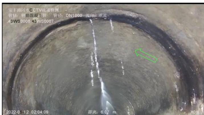
图 3.2- 3 管网渗漏示意图图
