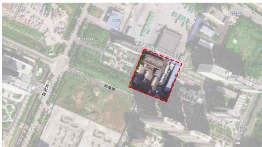
图 3-17 环卫处停车场航拍图
