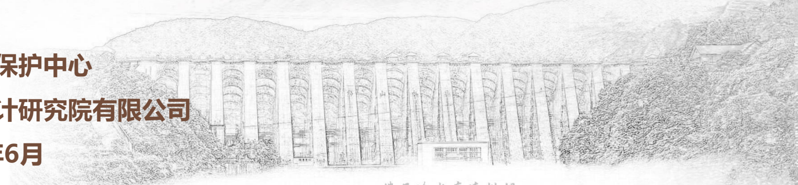
佛子岭水库连拱坝
