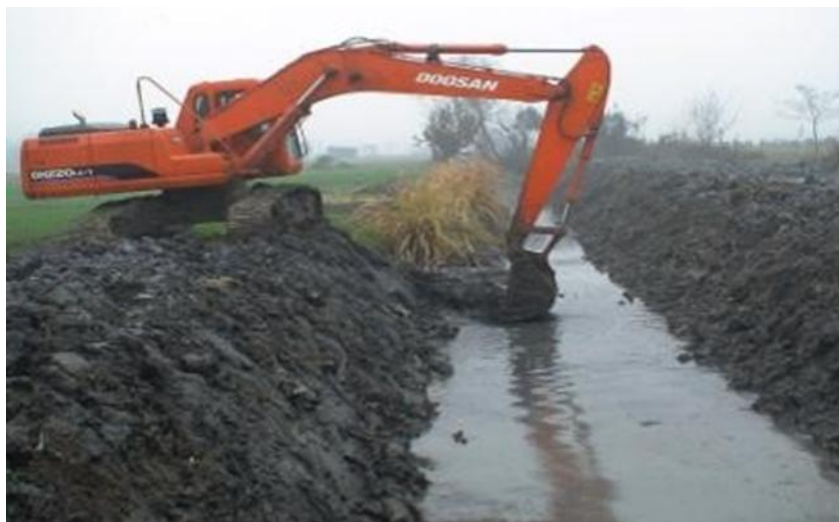
图 5.2- 1 挖机干法清淤现场
