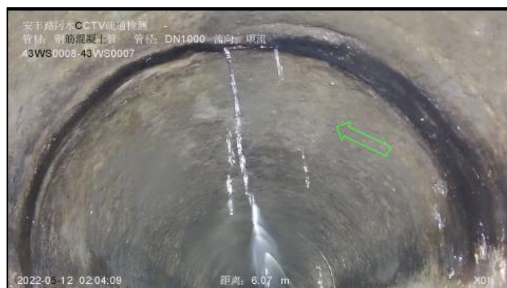
图 3.2- 3 管网渗漏示意图图
