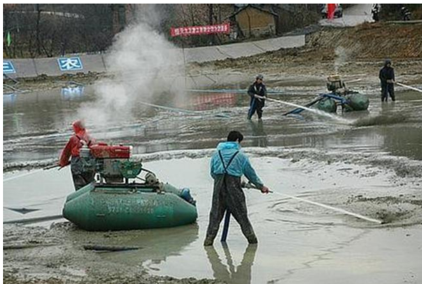
图 5.2- 2 水力冲挖清淤现场
