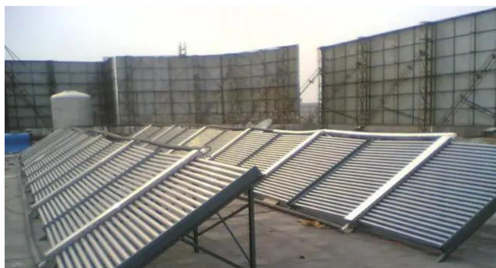
太阳能水管有序布置
