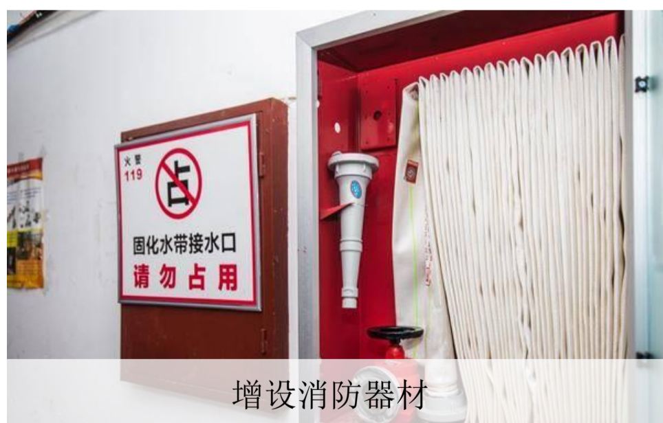
小区消防栓改造
