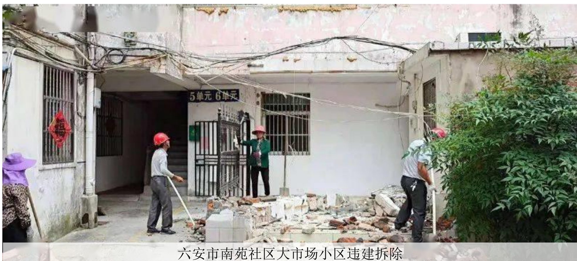
六安市九墩塘新村和锦绣花园违建拆除
