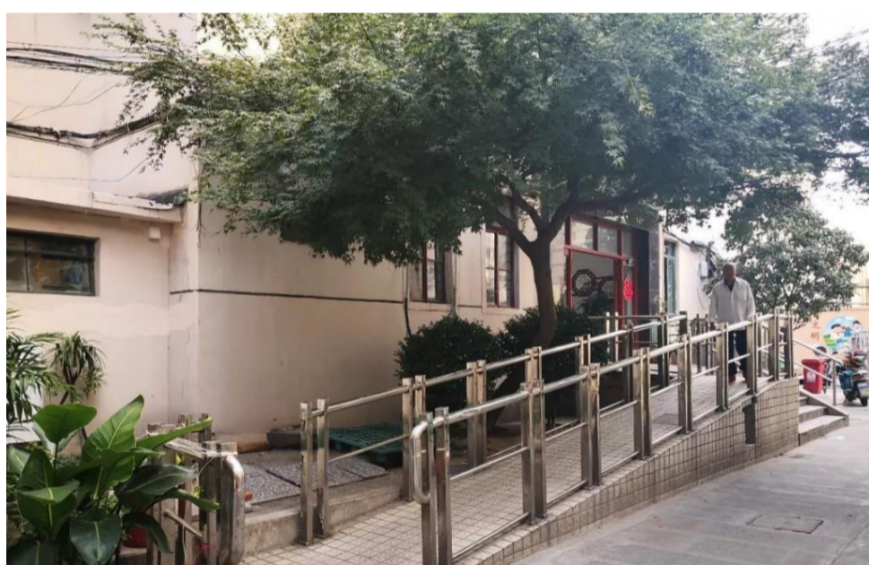
增补无障碍坡道、台阶等
