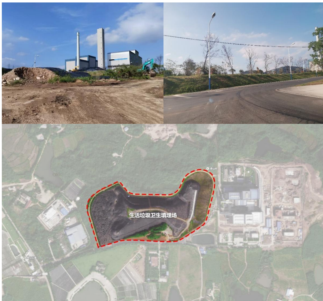
图 3-6 六安市生活垃圾卫生填埋场
