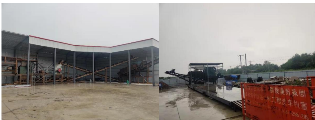
图 3-13 裕安区临时建筑垃圾消纳场所现场图
