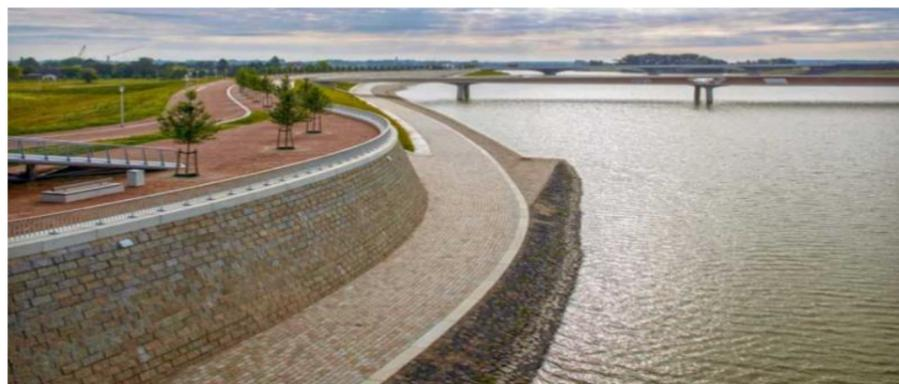
通过以上方案比选，村庄段河道采用叠石或生态框护岸，其余区域采用固宾笼护岸。直立式挡墙或护脚结构中，对于景观需求较高的河段可考虑采用叠石护岸做法，其中河道顶冲段及流态复杂河段优先采用灌砌石叠砌或叠石体背水侧细石砼回灌做法，现状滩地发育良好冲刷压力不大的河段可考虑采用干叠。对于新建护岸保护农田的河段，可采用块石材料，其中迎水侧考虑防冲可采用 C25 灌砌石(或 M10 浆砌石)外口 10~15cm 不露浆、以提供植物生长、鱼类栖息躲避的空间，背水侧则优先采用多孔隙投资经济且较为生态的干砌块石挡墙。直立式断面适用于用地紧张、空间狭小的、河岸紧邻河道深槽的河段。冲刷严重河段，拟采用直立式或复式断面挡墙结构形式，材料为灌砌或半灌砌石挡墙。
