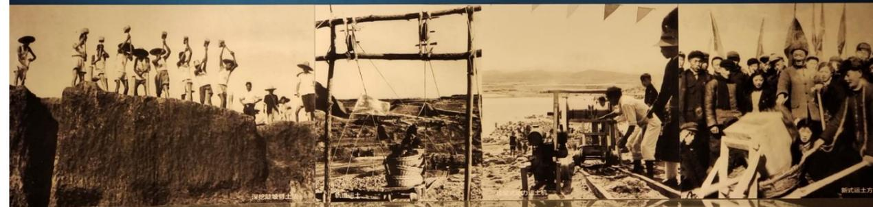
**顽强拼搏。**淠史杭工程完全是白手起家建造，面对种种困难，广大建设者土法上马，顽强拼搏，创造了专攻切岭工程的“洞室爆破法”、专攻黄僵土的“劈土法”，研制了垂直运输土工具“倒拉器”；以“党指向哪里，就打到哪里，就是脱掉两层皮，掉上几斤肉，也要切开平岗岭”的拼搏精神，终于实现了“叫高山低头，要平岗让路”的目标。1959年3月龙河口大坝施工时，连降大雨，水位陡涨，施工难度加大，舒城县以8万人大会战的态势，夺取了“水涨一寸，坝高一尺”的赫赫战果。
