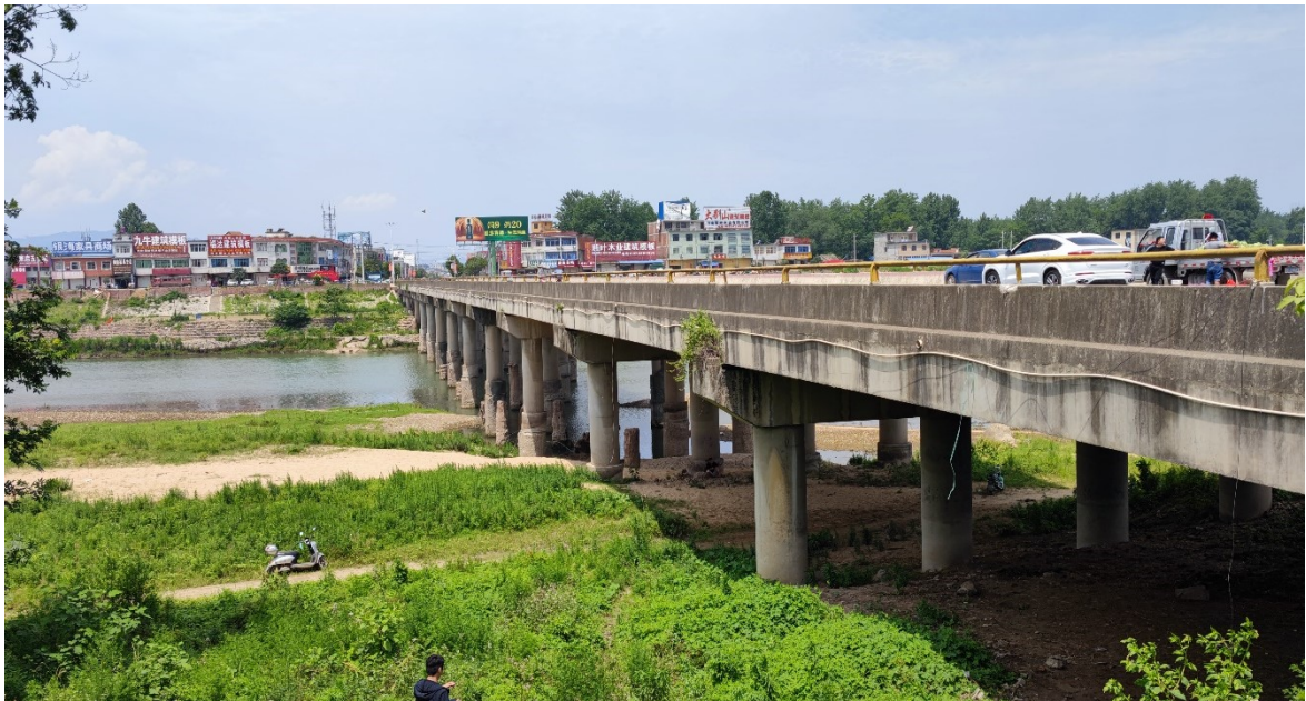
陈淋大桥现状照片
