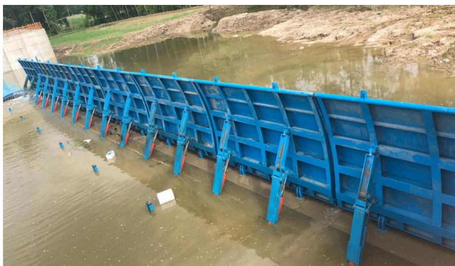
液压连杆翻板闸门竖起状态背面效果图
