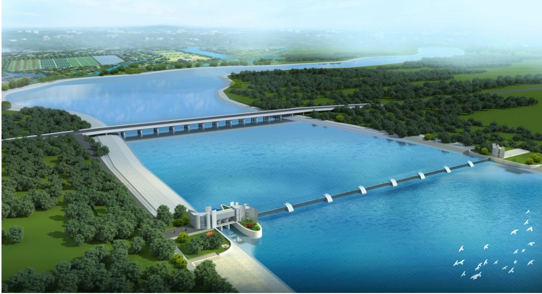
钢坝闸工程枢纽总体俯瞰图（自下而上）
