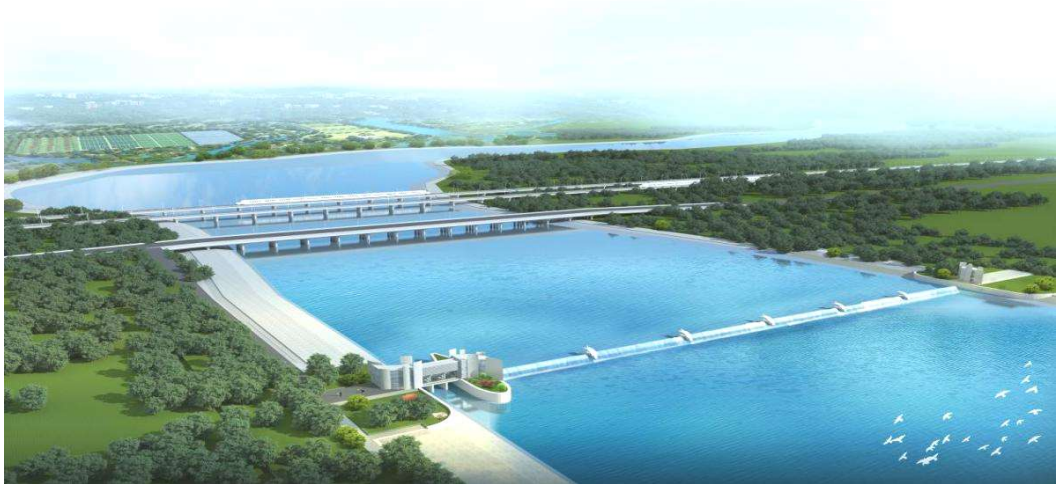
充水式橡胶坝工程枢纽总体鸟瞰图（自下而上）
