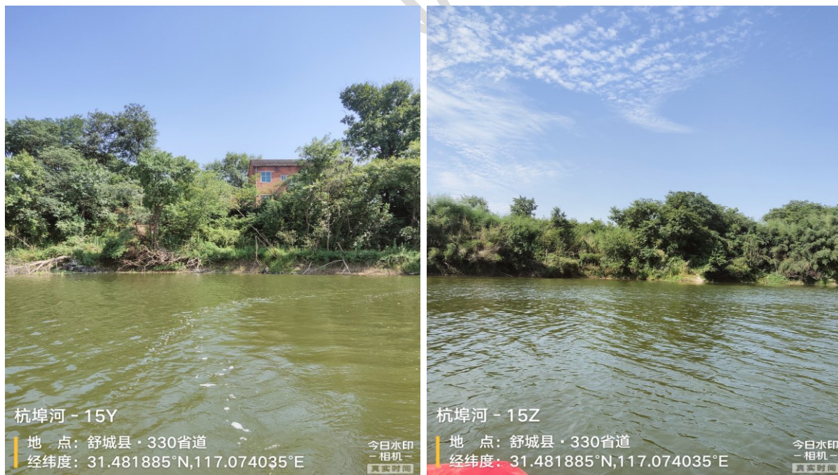
图 5.1-2 千人桥圩段堤防现状情况图
