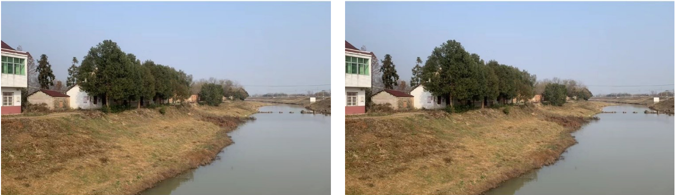
图 5.1-24 朱槽沟下游段
