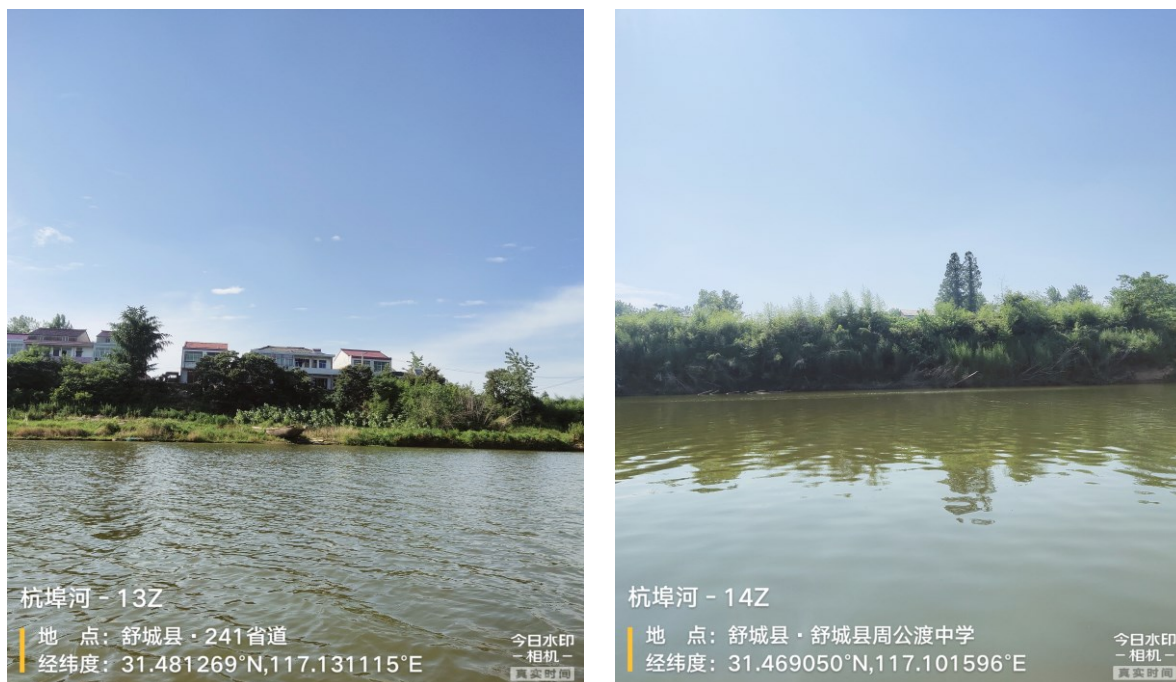
图 5.1-5 周公渡圩段堤防现状情况图
