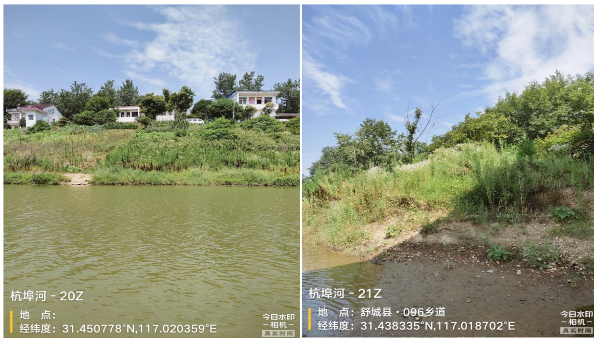
图 5.1-3 十二圩段堤防现状情况图
