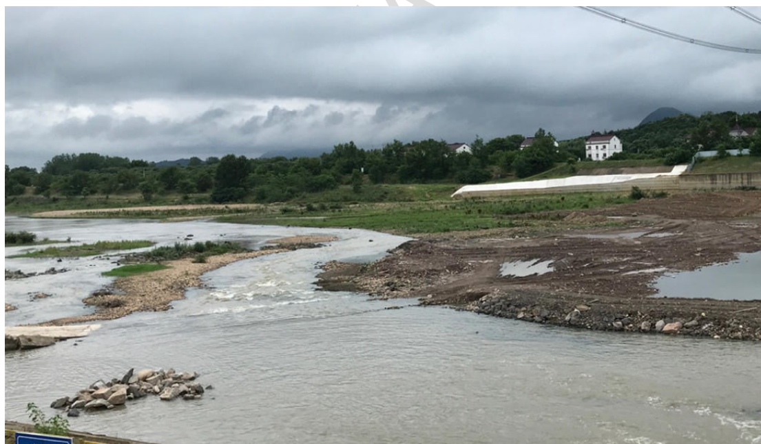
图 12.2-16 七门堰坝环境现状
