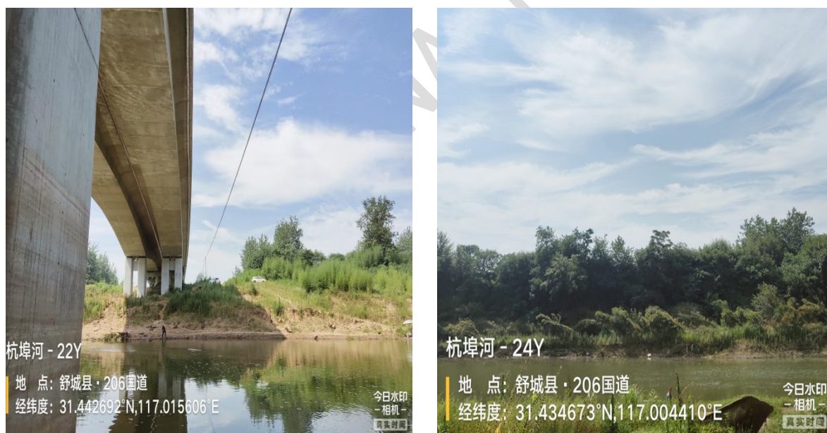
图 5.1-4 城南大圩段堤防现状情况图
