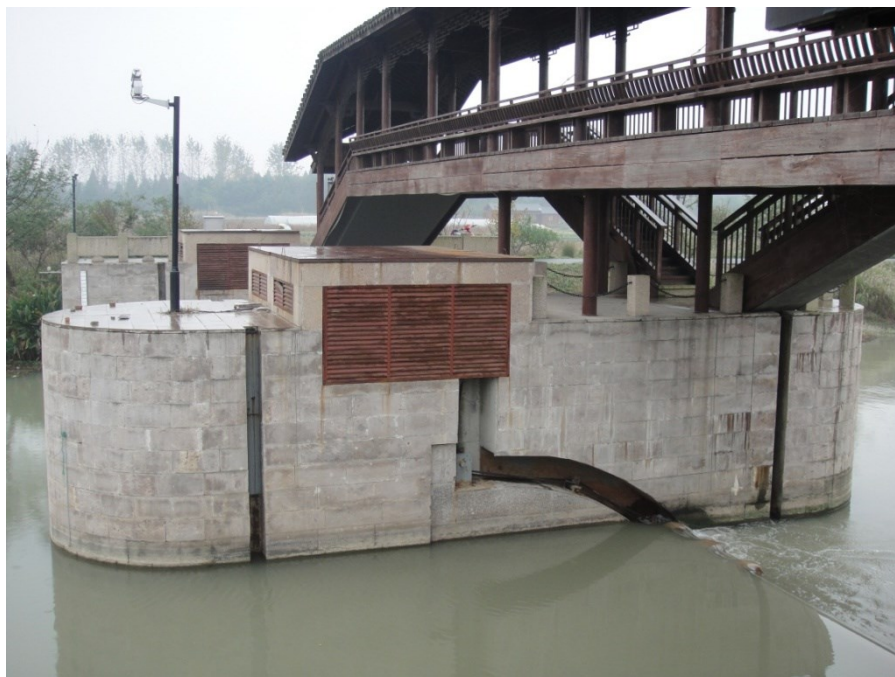
图15.1.2-6 可倾斜调节闸门照片
