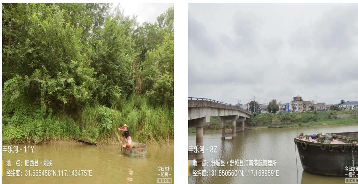
图 5.1-9 杭埠大圩段堤防现状情况图
