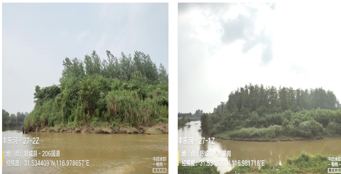
图 5.1-7 九里十三圩段堤防现状情况图
