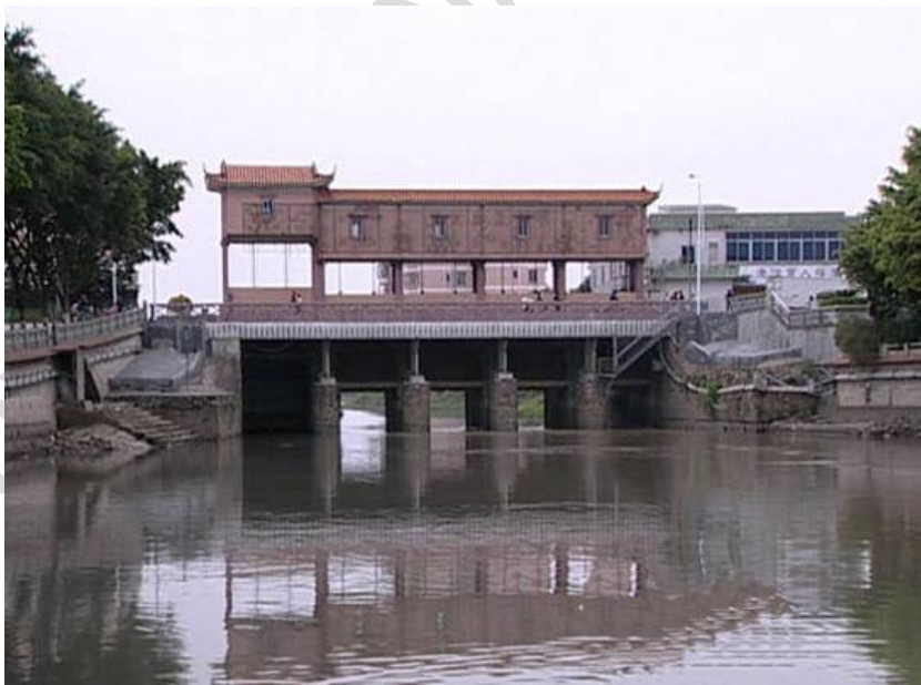
图 15.1.2-5 上提式平板闸门照片
