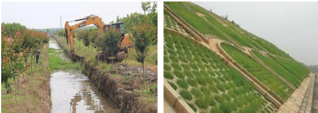
图 6.7-3 渠道清淤及生态护坡建设示例
