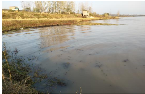
d) 东湖闸旁一处农居旁岸坡坡
