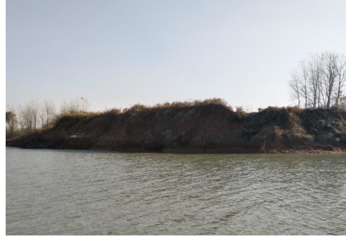
b) 城东湖北部湖面周围岸坡坡
